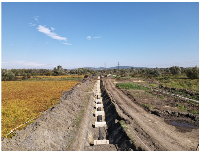
Eine Wasserleitung in Chernivtsi wird saniert.
