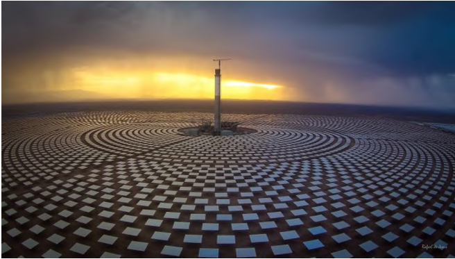
Afrikas erstes großes Solarkraftwerk: Blick auf NOORo III. Quelle: MASEN
