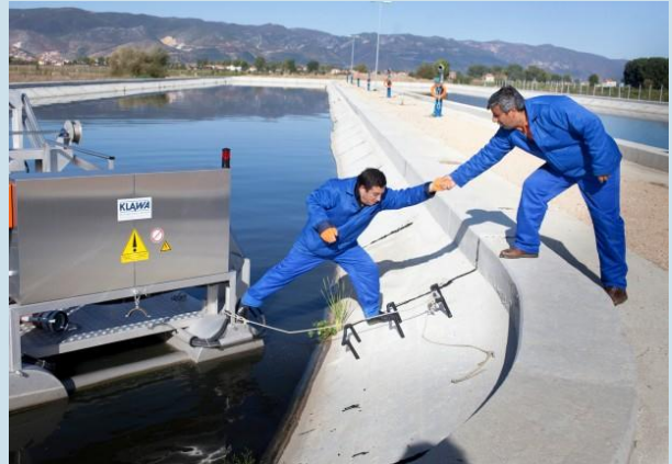
Sauberes Wasser gibt es nur in einem gut geführten Versorgungsnetz. Quelle: KfW-Bildarchiv / Ruben Ortiz
