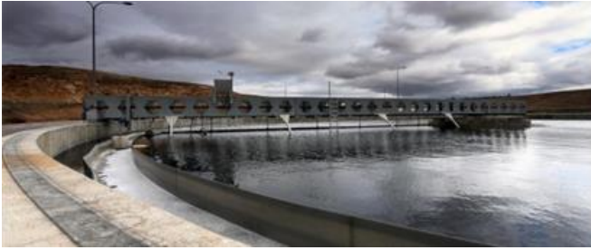
Kläranlage in Irbid. Quelle: KfW Bildarchiv, Urheber: auslöser photographie
