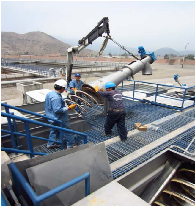
Die KfW Entwicklungsbank finanziert den Bau von Kläranlagen für die Stadt Lima. Quelle: KfW, Urheber: Charlotte Berkenfeld
