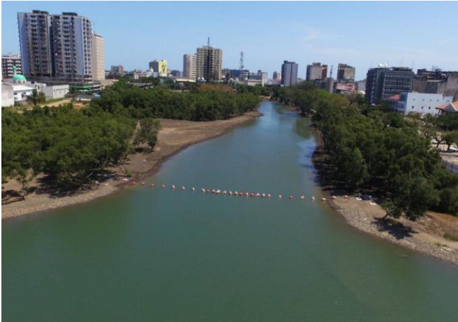
Rehabilitierter Flusslauf. Photo: Inros Lackner, SE
