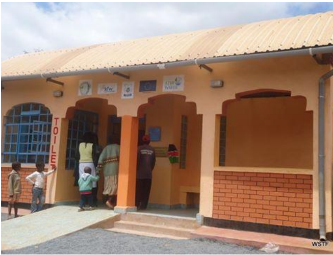
Öffentliche Toilettenanlage in Kiambu County. Quelle: WSTF
