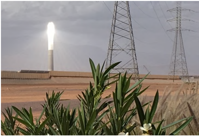
Afrikas erstes großes Solarkraftwerk: Blick auf den Turm von NOORo III. Quelle: KfW Bankengruppe, Urheber: Florian Ziegler
