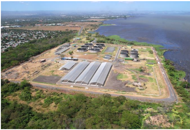
Die neue Kläranlage macht den Managuasee wieder zu einem attraktiven Gewässer vor den Toren der Hauptstadt. Quelle: KfW
