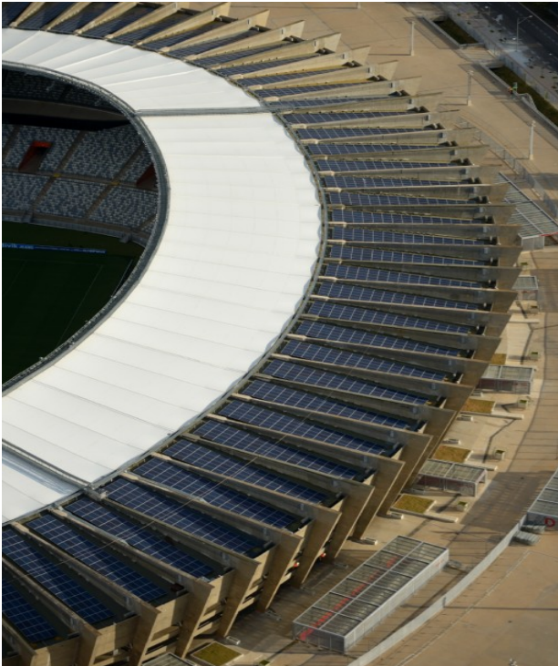
Eine Photovoltaik-Anlage auf dem Dach des WM-Stadions speist Strom ins brasilianische Netz. Quelle: KfW-Bildarchiv / Florian Kopp.
