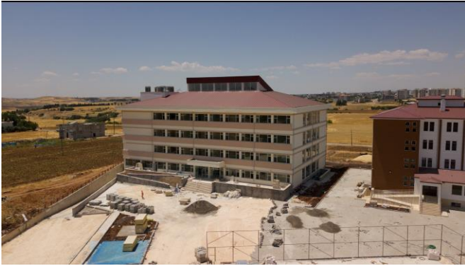
Massivbauschule in Adiyaman kurz vor Fertigstellung der Bauarbeiten. Urheber: Türkisches Bildungsministerium
