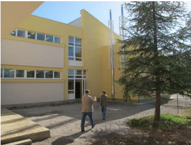
Die Njegos Spuz Schule in Danilovgrad erstrahlt in neuem Glanz. Quelle: KfW / Ralf Kynast
