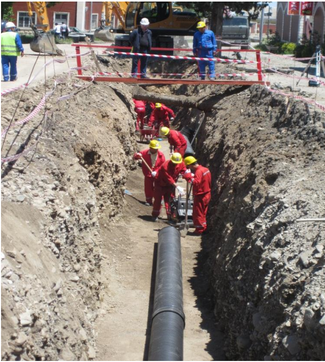
Wasserleitungen in Ganja und Sheki werden erneuert. Quelle: KfW Entwicklungsbank/Ursula Heister
