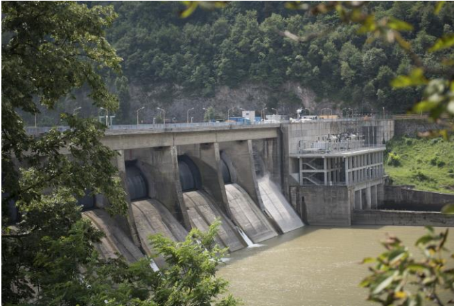
Das WKW Zvornik, . Quelle: KfW-Bildarchiv, Urheber: Miodrag Bogdanovic
