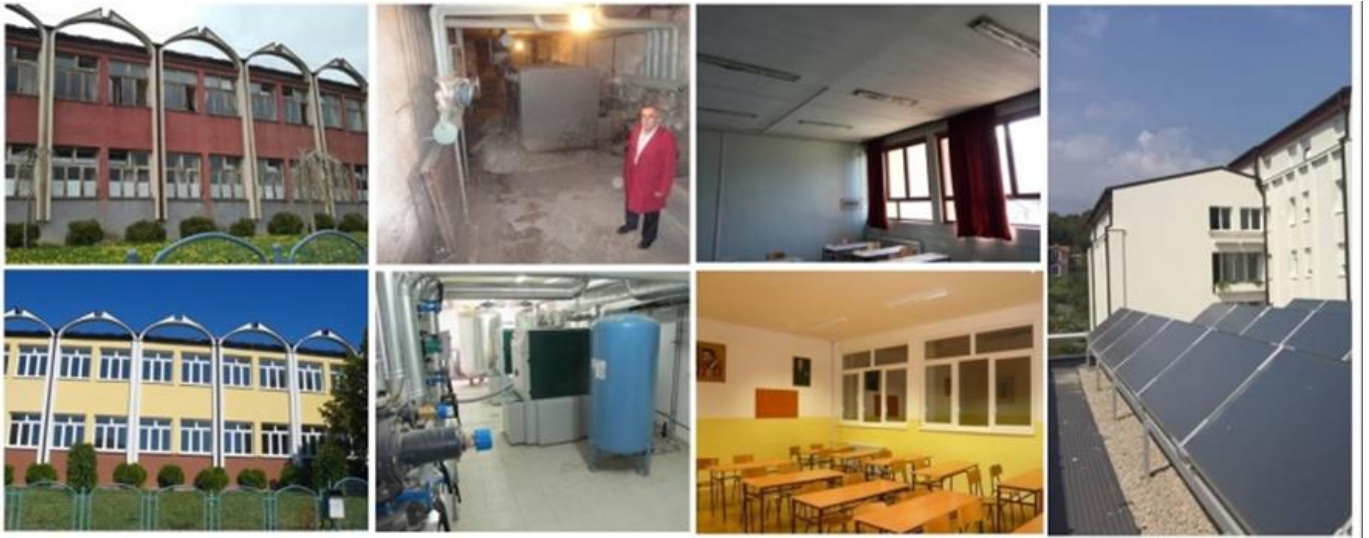
Energetische Sanierung einer Schule aus Phase I, oben: vorher, unten: nachher. Rechts: Solarthermie auf dem Dach eines Wohnheims für Auszubildende. Quelle: KfW Bankengruppe, Urheber: Ralf Kynast
