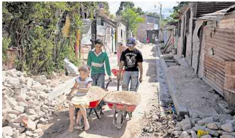
Die Anwohner beteiligen sich beim Pflastern der Wege und der Sanierung des Viertels. Foto: KfW-Bildarchiv/Bernhard Schurlian
