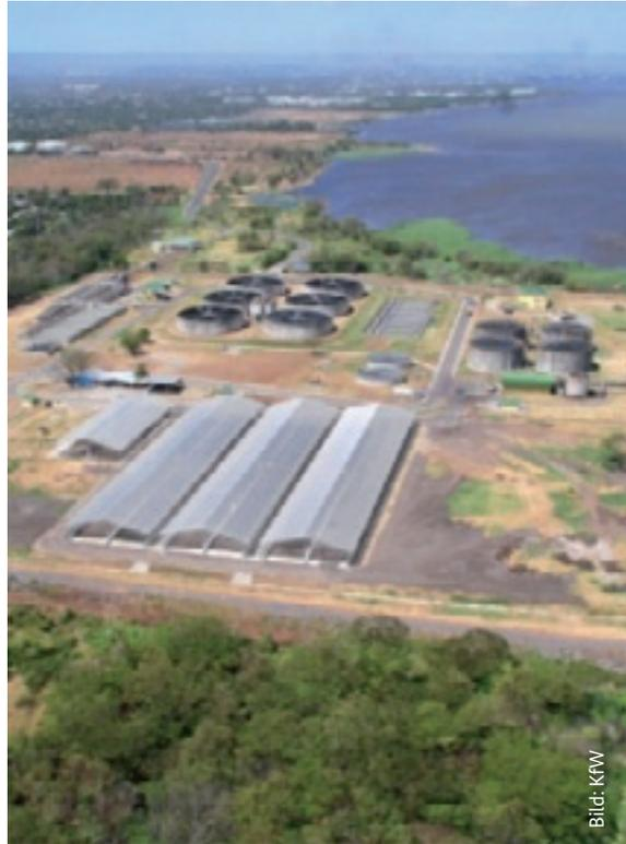
Nach umfangreichen Studien befand man eine Kombination aus passiv-solarer Klärschlamm-trocknung und Wiederverwendung in der Landwirtschaft als am besten geeignet. Durch die Installation einer solaren Klärschlamm-trocknungsanlage wurde der Energiebedarf von jährlich 800-1.000 kWh/ t auf 20 kWh/ t reduziert, da der Solartrockner wesentlich weniger Energie benötigt. Einhergehend ist damit eine deutliche Reduzierung der Betriebskosten der Anlage.
