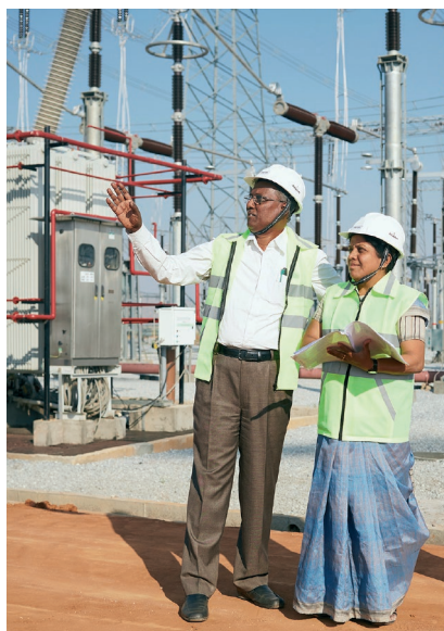
Übertragungsleitungen und Umspannstationen speisen nachhaltig erzeugten Strom ins indische Stromnetz ein, um ihn dorthin zu transportieren, wo er am dringendsten gebraucht wird.
