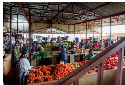
Ruanda: Unter Hallendächern in offener Ständerbauweise können Märkte und andere Veranstaltungen organisiert werden. Quelle: KfW / Rendel Freude
