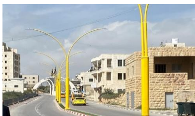
Straßenrehabilitation und Beleuchtung am Städteingang von Janata. Quelle: KfW / Hannah Linnemann
