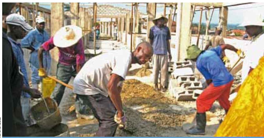
Baustelle im Osten der Demokratischen Republik Kongo.
