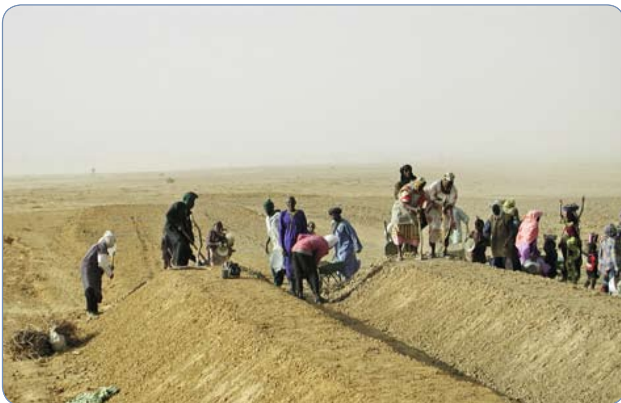
Kanalbau durch die Trockensavanne.
