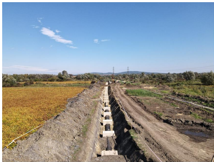
Eine Wasserleitung in Chernivtsi wird saniert. Quelle: Hennadii Dudko, Head of Strategic Development Department of Chernivtsivodokanal
