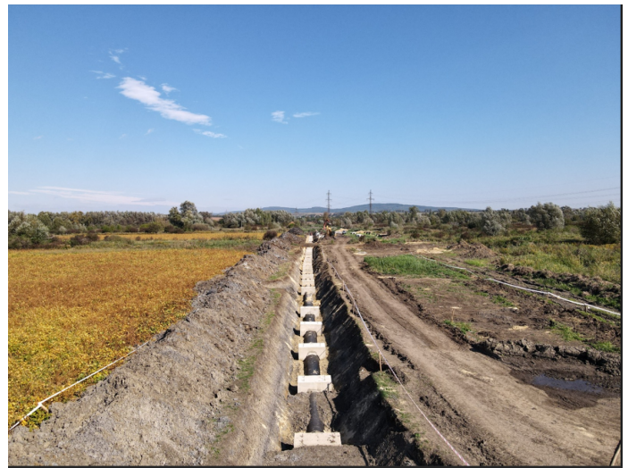
Eine Wasserleitung in Chernivtsi wird saniert. Quelle: Hennadii Dudko, Strategic Development Department of Chernivtsivodokana
