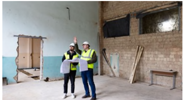
Baustelle eines neuen Gebäudes, Aufgenommen in der Region Chernivtsi, Ukraine 2024
