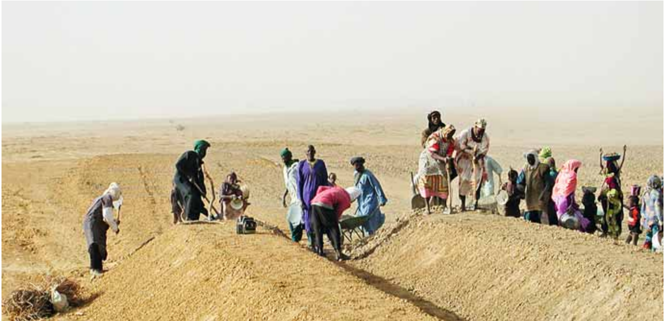
Kanalbau in der Trockensavanne
